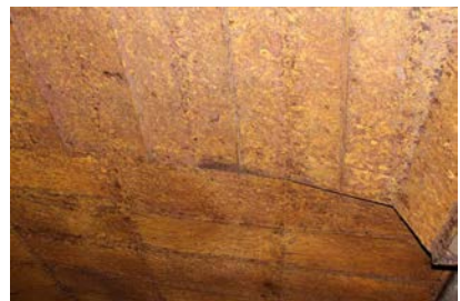
... impozantní podzemní strojovna má strop „vykládaný“ železnými pláty...
