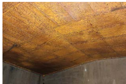
... impozantní podzemní strojovna má strop „vykládaný“ železnými pláty...
