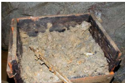
... jinde s jilem na ucpávky (šulky) vývrtů pro střelné práce...
