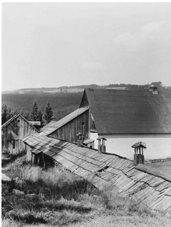
Vodní štola Dolu Werner už čekala na pořádnou opravu (1945)
