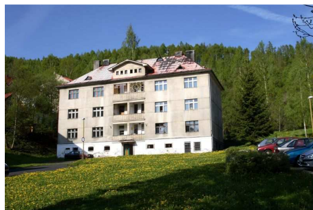
tzv. „Rusák“ na jáchymovských Slovanech stojí v předpolí mohutné třípatrové haldy a dosud se tváří budovatelsky; dnes je ale vybydlen a zralý k demolici
